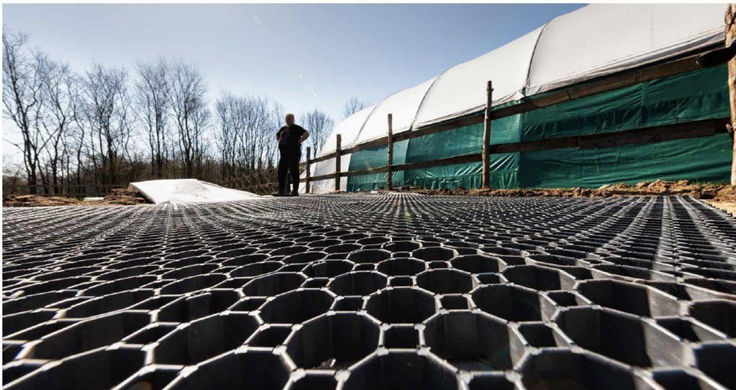
Montaż na padoku
