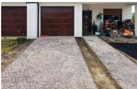
Wjazd do garażu
